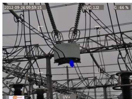
Рис. 5-8. Коронные разряды в реальных условиях действующих электросетей
