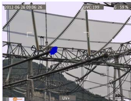
Рис. 5-8. Коронные разряды в реальных условиях действующих электросетей
