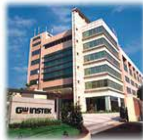
Штаб квартира и фабрика, Тайвань
